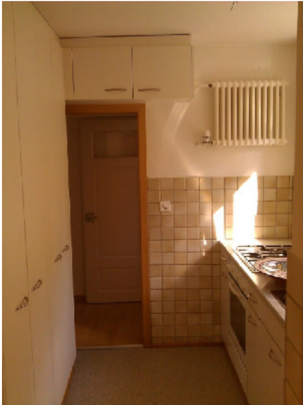
Radiator. Goldackerweg 4, 8047 Zürich
